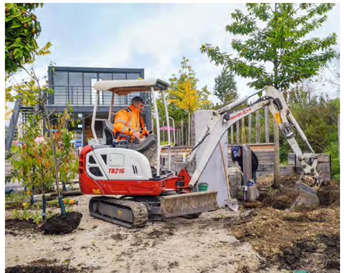
Rückbau des Lehrgartens Anfang Oktober mit Ausgraben der Bäume
